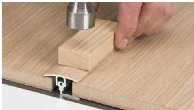
Instalace přechodového profilu hliníkového
