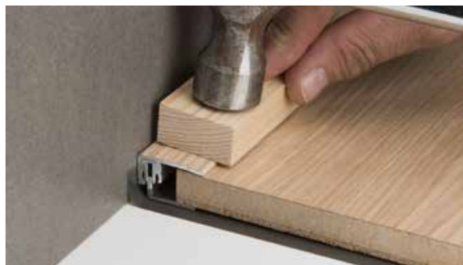
Instalace ukončovacího profilu hliníkového
